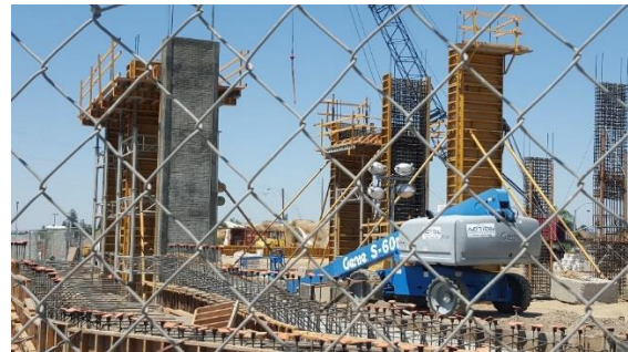
Santa Fe Pedestrian Grade Separation (Tulare, CA)
